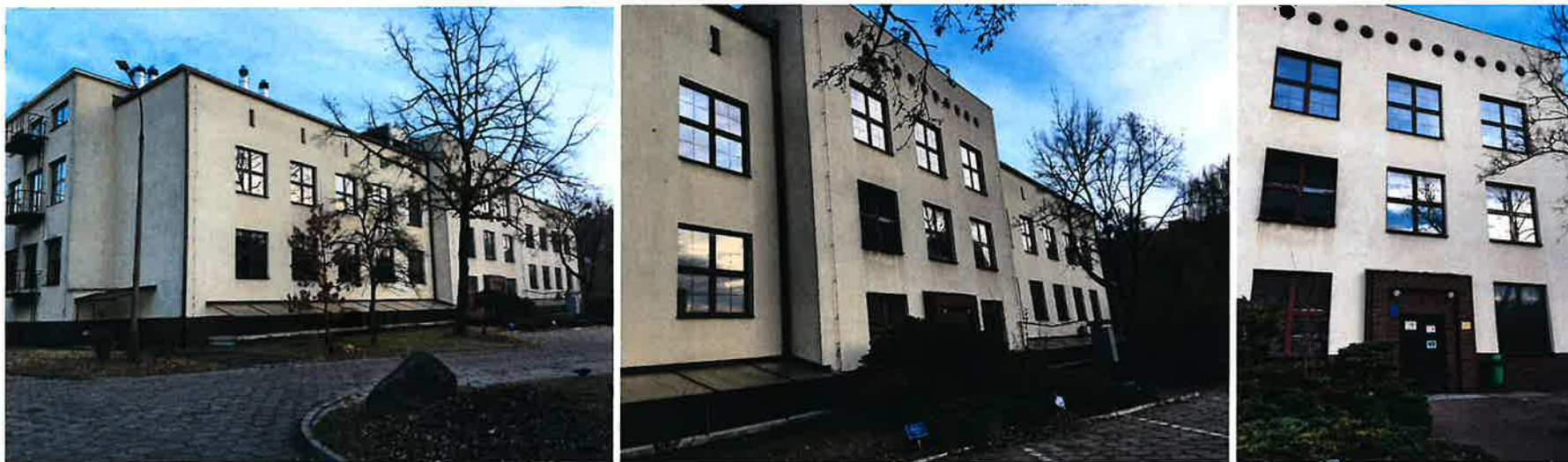
IL. 10-12. Widok elewacji frontowej: od strony zach. (10, 11) i fragment środkowy (12).
